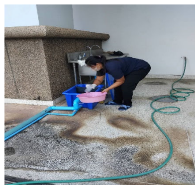
การตัดคราบไขมันและทำความสะอาดถังดักไขมัน ชั้น 1 ด้านหลังอาคาร
