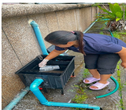
การตัดคราบไขมันและทำความสะอาดถังดักไขมัน ชั้น 1 ด้านหน้าอาคาร
