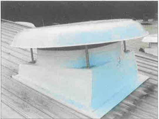
พัดลมหลังคา 36 นิ้ว 1 HP 380V 10P 550RPM 50HZ AIR FLOW 34,000CMH
