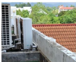
งานเดินระบบระบายน้ำใหม่
