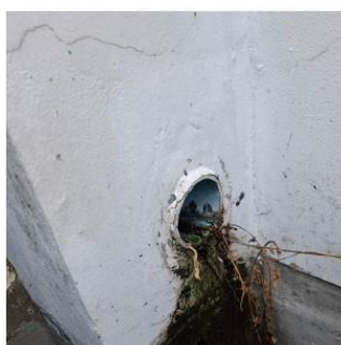
งานเดินระบบระบายน้ำใหม่
