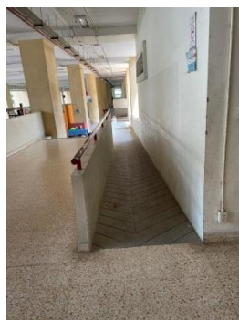
ทางลาดขึ้นอาคาร
