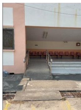
ทางลาดขึ้นอาคาร
