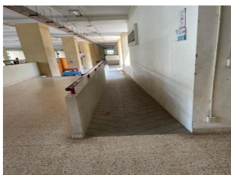
ภาพที่ 7.4.7 ทางลาดขึ้นอาคาร
