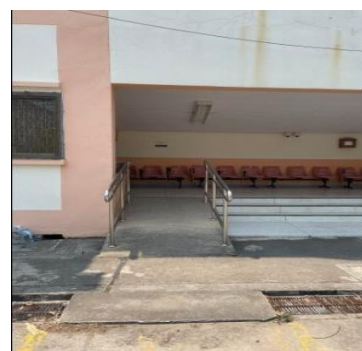
ภาพที่ 7.4.9 ทางลาดขึ้นอาคาร
