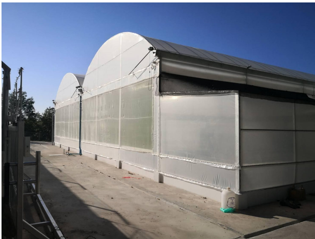
ภาพ 11 โรงเรือนปลูกพืชในระบบ EVAP พร้อมชุดควบคุมสภาพแวดล้อม ขนาด 9.6 x 40 เมตร
