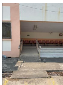
ทางลาดขึ้นอาคาร
