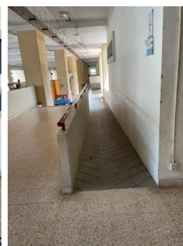
ทางลาดขึ้นอาคาร
