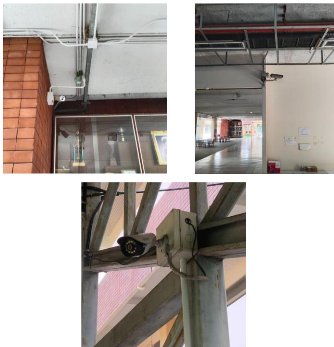
รูปที่ 7.6.3 การติดตั้งระบบกล้องวงจรปิด
