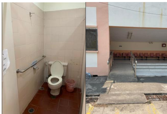
ภาพที่ 7.6.3 ห้องน้ำ และทางขึ้นอาคาร สำหรับผู้พิการหรือผู้บกพร่องทางร่างกาย อาคารเสาวรัช นิตยะวรรณะ
