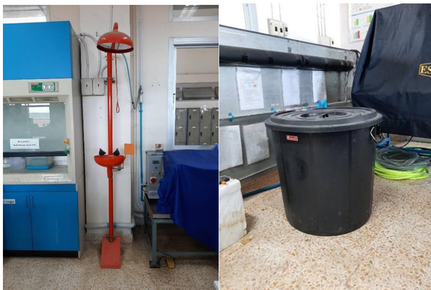
ภาพที่ 7.6.6 ชุดฝึกบัวและอ่างล้างตาฉุกเฉินภายในห้องปฏิบัติการ
