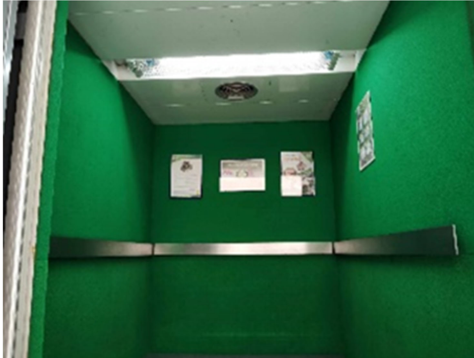
เปลี่ยนหลอดไฟเป็นหลอด LED (T8) ภายในลิฟท์อาคาร
