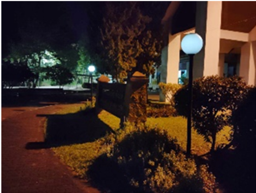
ติดตั้งโคมไฟฟ้าพลังงานแสงอาทิตย์ 2 หลอดที่หน้าอาคาร
