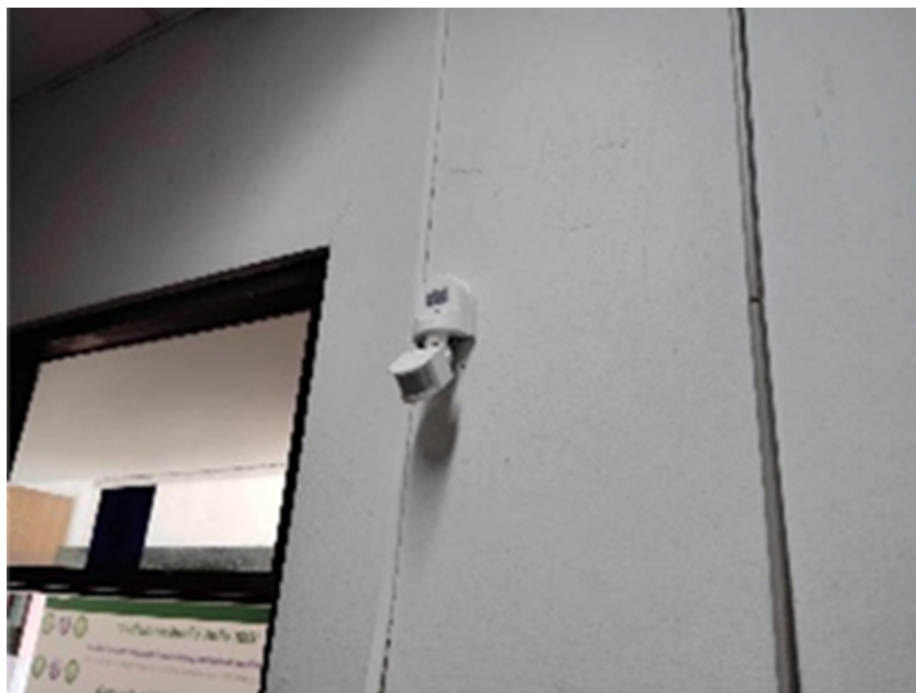
ติดตั้งเซนเซอร์เพื่อเปิด-ปิดหลอดไฟภายในห้องน้ำชาย และหญิง
