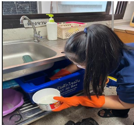
ภาพที่ 4.31 การดักคราบน้ำมันและทำความสะอาดถังดักไขมัน
