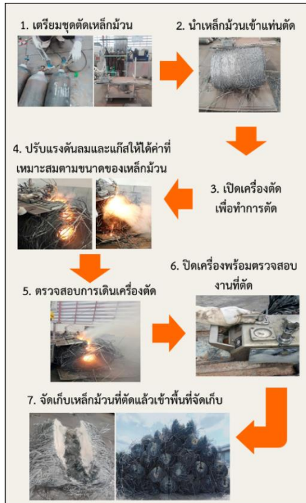
รูปที่ 4 ขั้นตอนการตัดเหล็กม้วน
