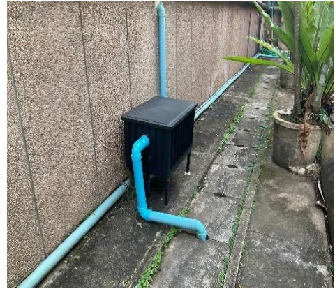
ภาพที่ 4.29 จุดติดตั้งถังดักไขมันบริเวณชั้น 1 อาคารเฉลิมพระเกียรติสมเด็จพระเทพรัตนราชสุดา
