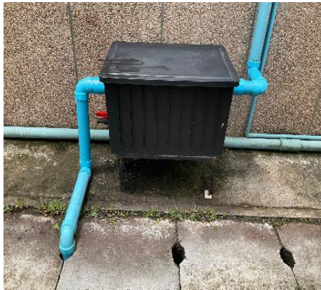
ภาพที่ 4.29 จุดติดตั้งถังดักไขมันบริเวณชั้น 1 อาคารเฉลิมพระเกียรติสมเด็จพระเทพรัตนราชสุดา
