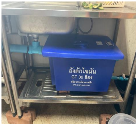
ภาพที่ 4.30 จุดติดตั้งถังดักไขมันบริเวณชั้น 3 อาคารเฉลิมพระเกียรติสมเด็จพระเทพรัตนราชสุดา
