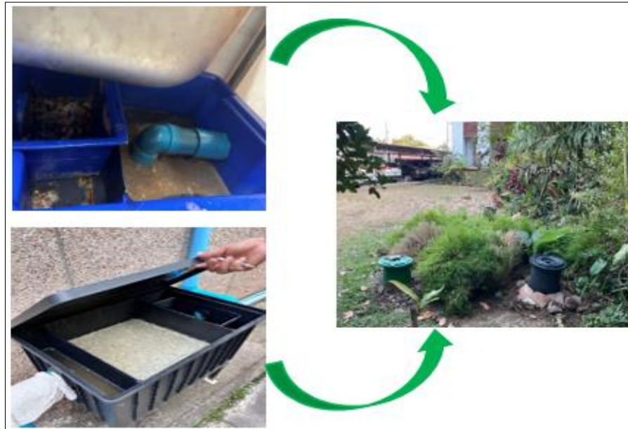
ภาพที่ 4.35 การตรวจสอบ ปรับปรุง ซ่อมแซมระบบบำบัดน้ำเสียให้สามารถใช้งานและมีประสิทธิภาพอยู่เสมอ
