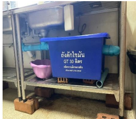
ภาพที่ 4.30 จุดติดตั้งถังดักไขมันบริเวณชั้น 3 อาคารเฉลิมพระเกียรติสมเด็จพระเทพรัตนราชสุดา
