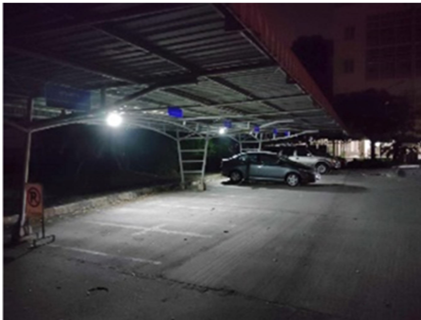
ติดตั้งโคมไฟพลังงานแสงอาทิตย์ 2 ดวงที่โรงจอดรถหน้าอาคาร
