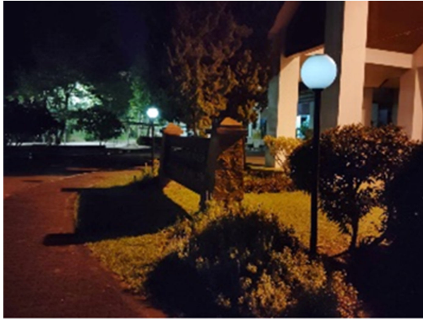
ติดตั้งโคมไฟฟ้าพลังงานแสงอาทิตย์ 2 ดวงที่หน้าอาคาร
