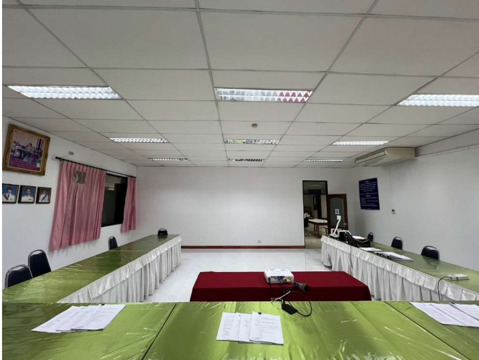
เปลี่ยนหลอดไฟภายในอาคารเป็นหลอด LED (T8)
