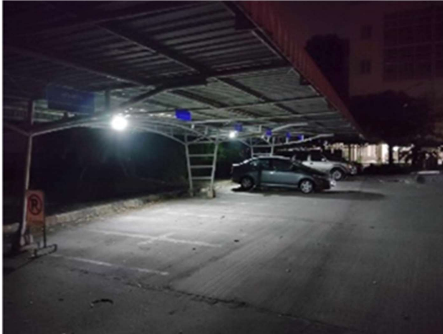
ติดตั้งโคมไฟฟ้าพลังงานแสงอาทิตย์ 2 ดวงที่โรงจอดรถยนต์หน้าอาคาร
