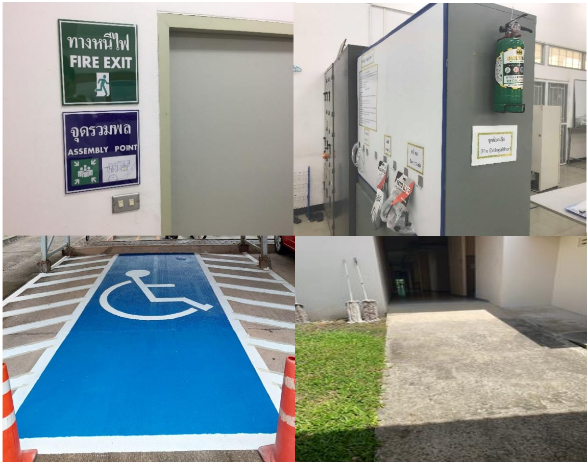
ภาพที่ 7.14 การรองรับด้านความปลอดภัย อุปกรณ์ป้องกันสารอันตรายภายในห้องเรียนและห้องปฏิบัติการ ที่จอดรถและทางเดินลาดเอียงสำหรับผู้ที่มีความจำเป็นพิเศษ
