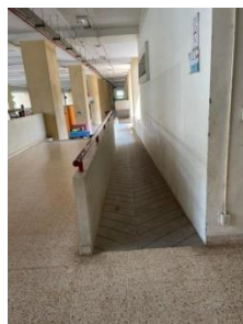
ทางขึ้นอาคาร
