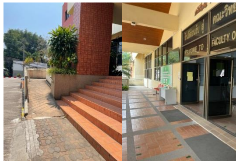
ทางขึ้นอาคาร
