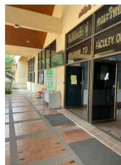
ทางขึ้นอาคาร
