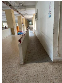
ทางขึ้นอาคาร
