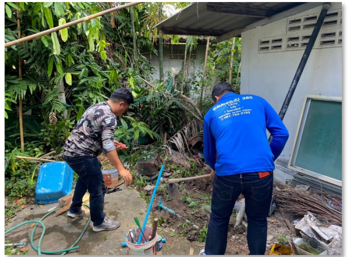
การซ่อมบำรุงการรั่วไหลของน้ำ เพื่อดำเนินการแก้ไขที่พบจากการตรวจสอบ
