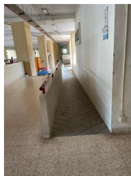
ทางขึ้นอาคาร
