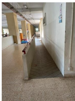
ทางขึ้นอาคาร
