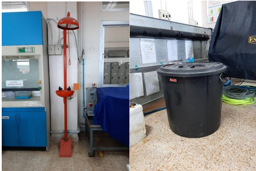
ภาพที่ 7.6.4 ชุดฝึกบัวและอ่างล้างตาฉุกเฉินภายในห้องปฏิบัติการ
