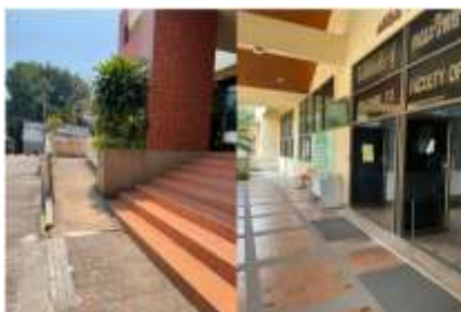
รูปที่ 7.6.2 ทางขึ้นอาคาร
